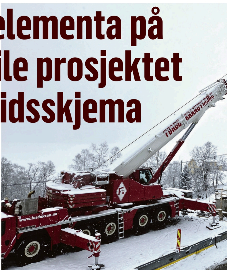
Her blir dei 28 meter lange brubjelkane i betong heiste på plass. Foto: Olav Klungre.
