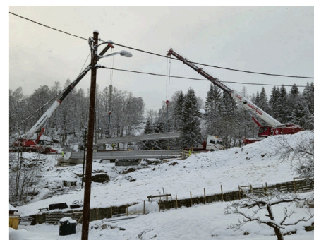
Kvart element vog 28 tonn. Til saman åtte betongbjelkar utgjør brua på Solheim. Foto: Olav Klungre.
