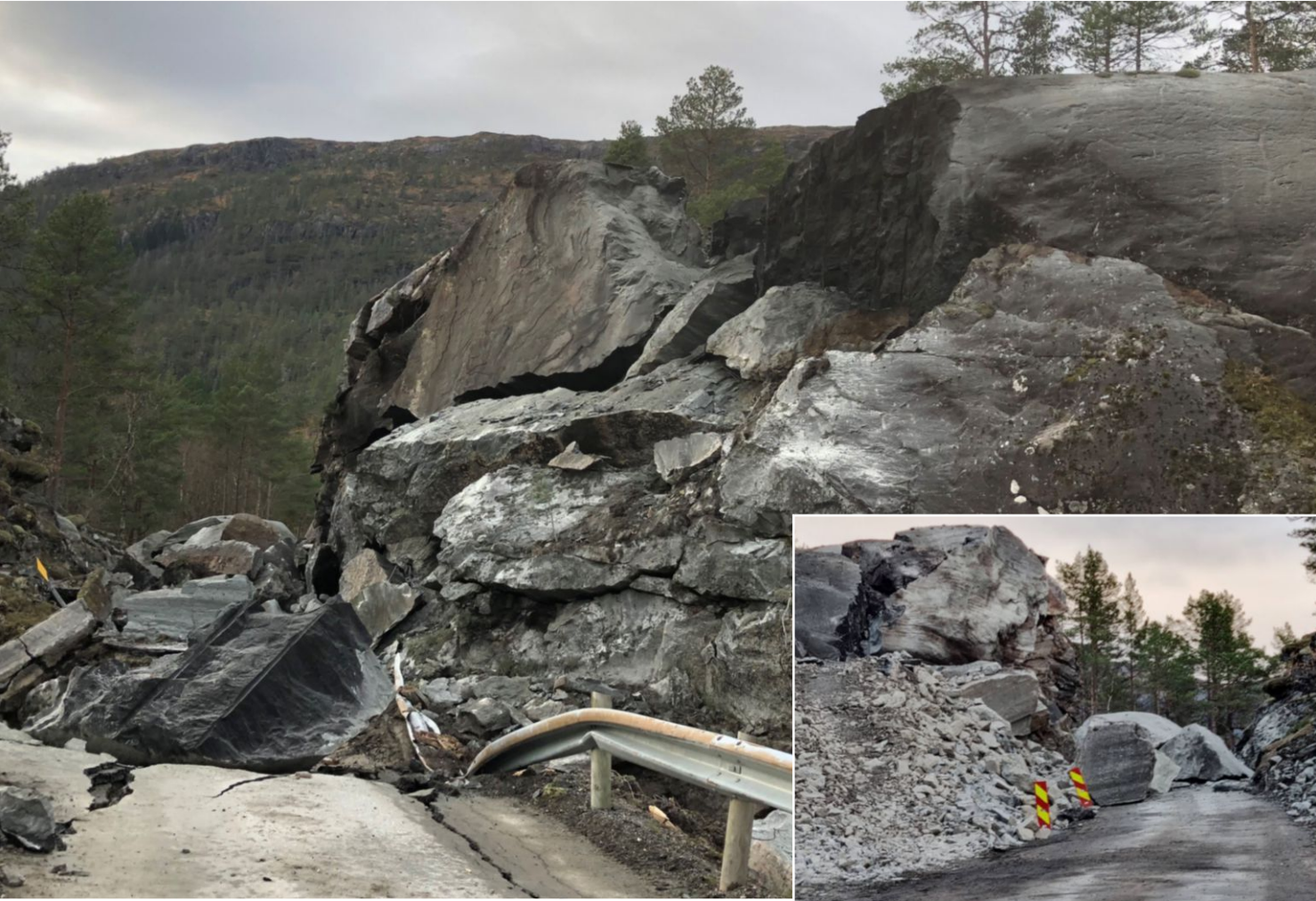
Store steinblokker rasa ut på fylkesvegen i samband med sprengingsarbeid ikkje langt frå Nesholmen. Begge foto: Vestland fylkeskommune.
