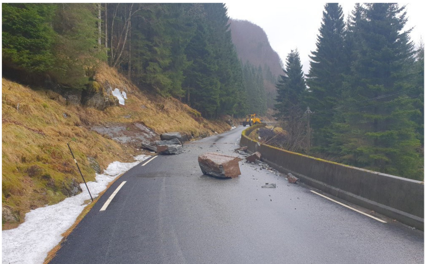
Fleire steinblokker rasa ned på Fv 615 i Hopsstranda måndag. Vegen var stengd i eitt døgn. Foto: Arild Straume.
